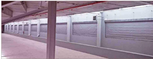
Barreras que se accionan automáticamente al recibir la señal de incendio son algunas innovaciones. Su objetivo es crear un cierre al paso del humo y las llamas. Están fabricadas con un material de fibra de vidrio.
